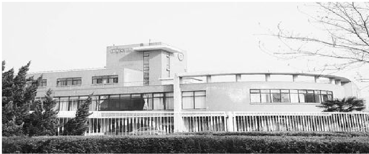
2001 年建成的地球环境所科研办公楼园区
